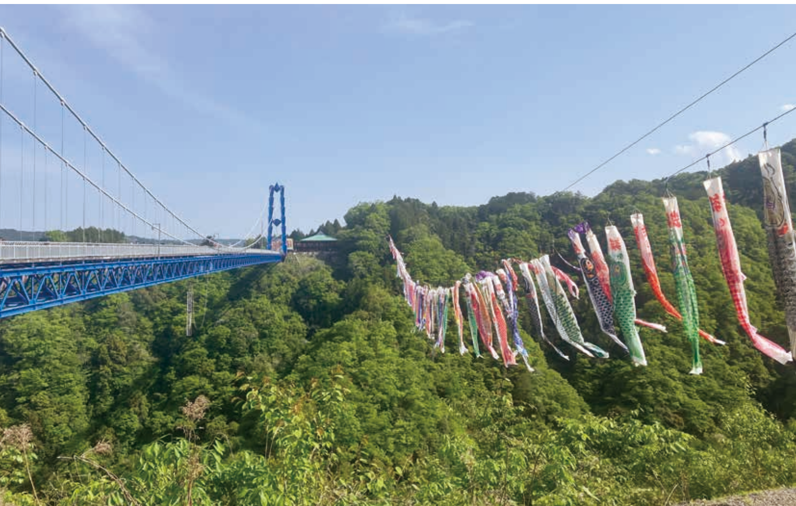
竜神大吊橋（常陸太田市）
